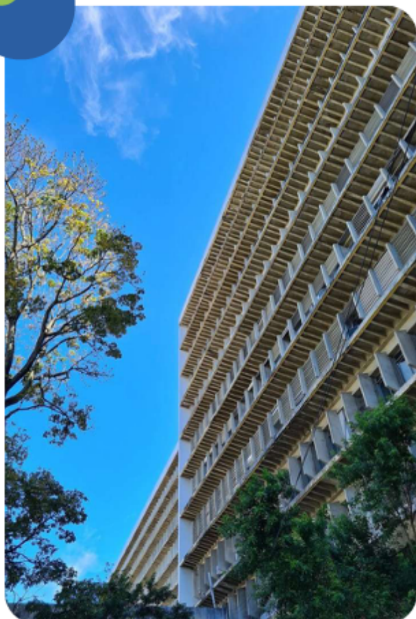
Figura (I). - Fachada do HC-UFPE
