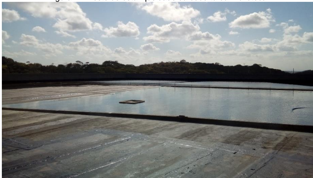
Figura 14. Teste de estanqueidade da cobertura da Biblioteca
