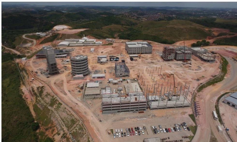
Figura 8. Desenvolvimento da obra em setembro de 2017
