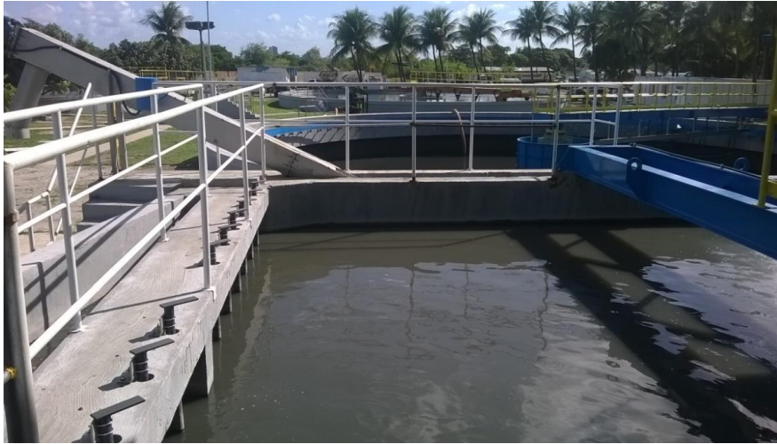
Figura 6. Caixa desarenadora existente na ETE.
