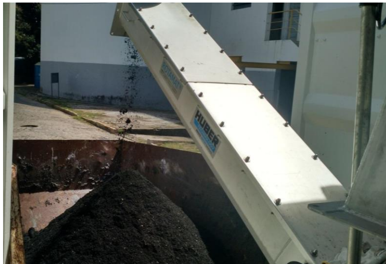
Figura 18. Lodo desidratado lançado em caçamba estacionária.
