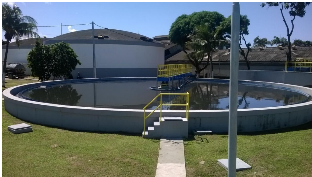
Figura 8. Um dos quatro decantadores que constituem o tratamento primário.
