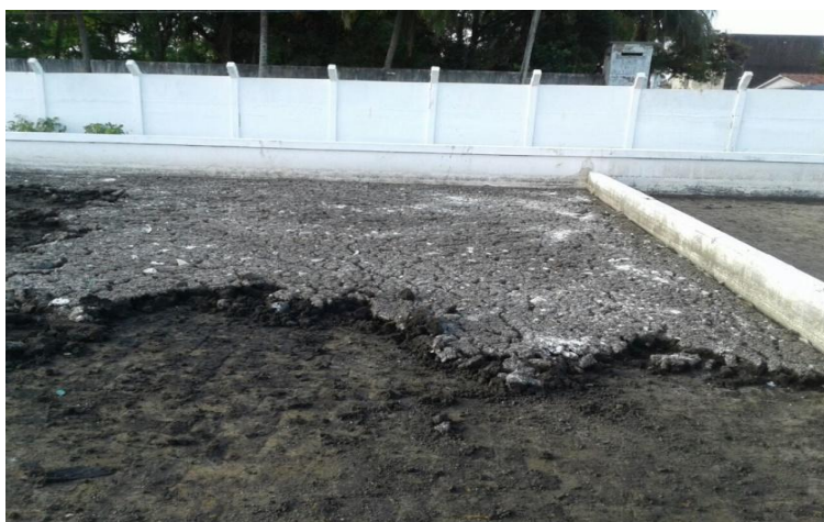
Figura 11. Uso de Cal hidratada sobre o lodo depositado.
